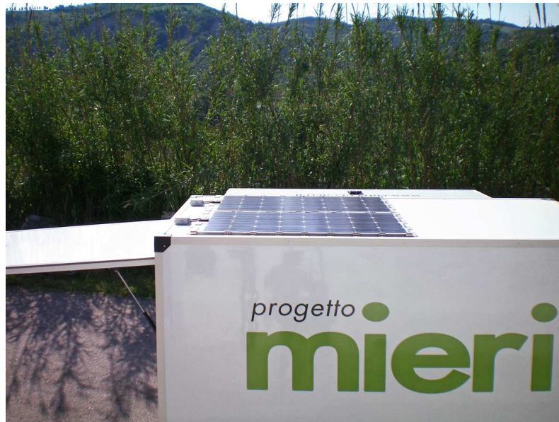
Figura 8 - Pannelli fotovoltaici installati sul tetto del negozio.
